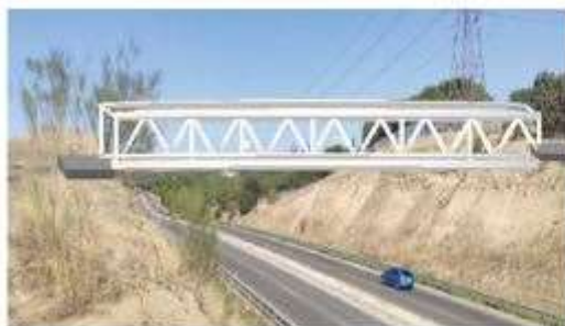
Pasarela Mina del Cazador sobre M-503
