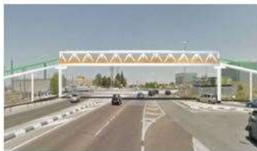
Pasarela Valdegrulla sobre M-603
