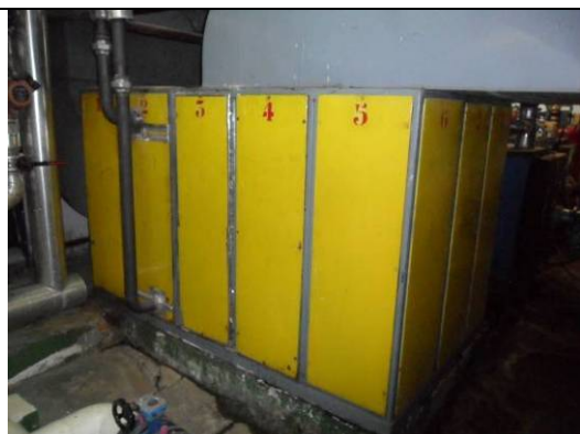
Climatizadora Piscina Cubierta
