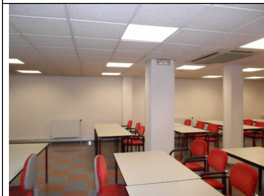
Iluminación Sala Reuniones. 2ª planta.
