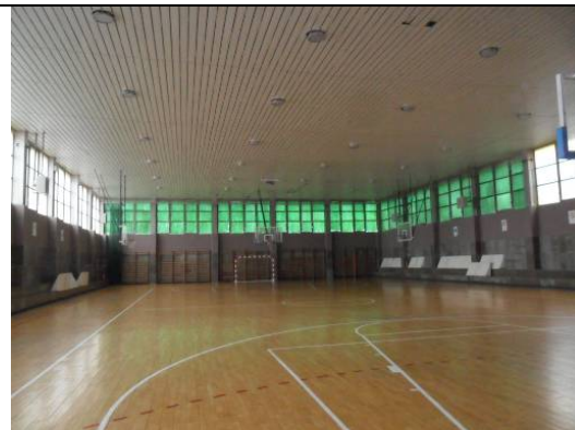
Iluminación Pabellón. 3ª planta.
