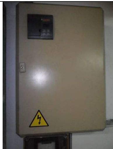
Batería condensadores
