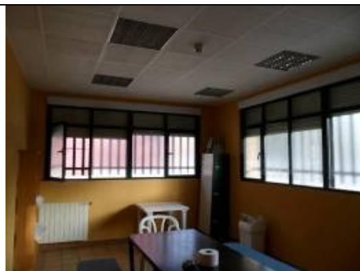
Carpintería exterior comedor
