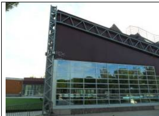
Carpintería exterior Piscina
